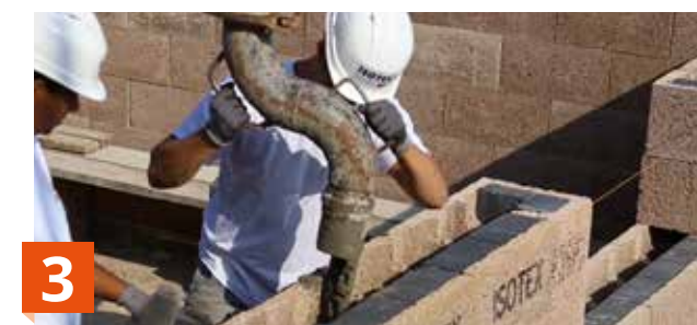
3 Relleno con hormigón los bloques (cada 6 hiladas).
