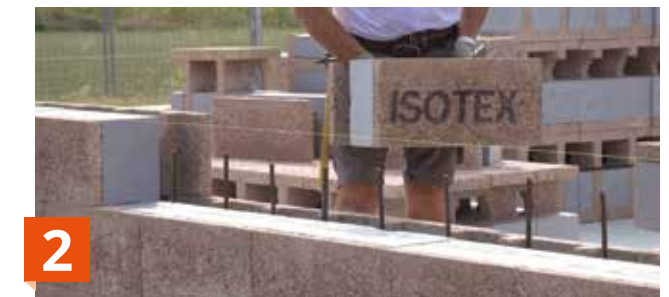
2 Las hiladas sucesivas se ponen en seco.
