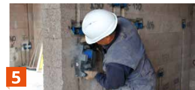
5 Realización de las canales para instalaciones.
