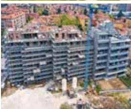
Edificio de 7 plantas en Bolonia (Italia)
