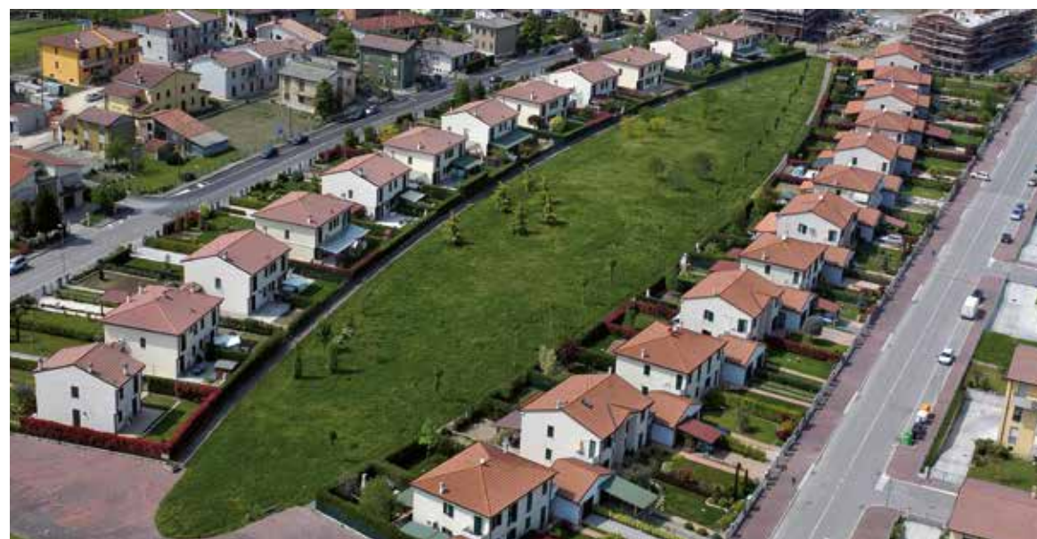
Intervento di 96 alloggi realizzati a VERONA - 1995
