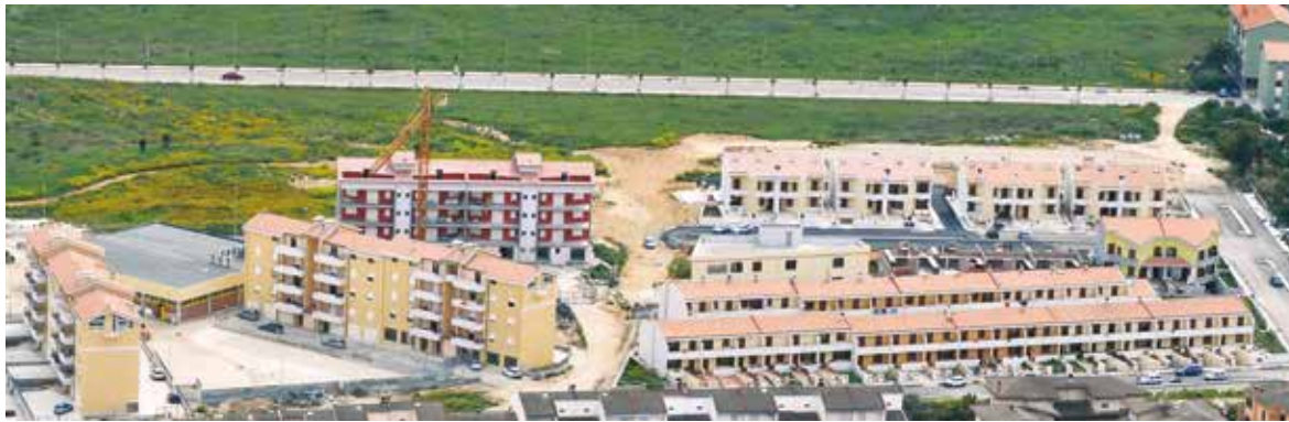
Intervento di 200 alloggi PORTO TORRES (SS) - 2004-2007
