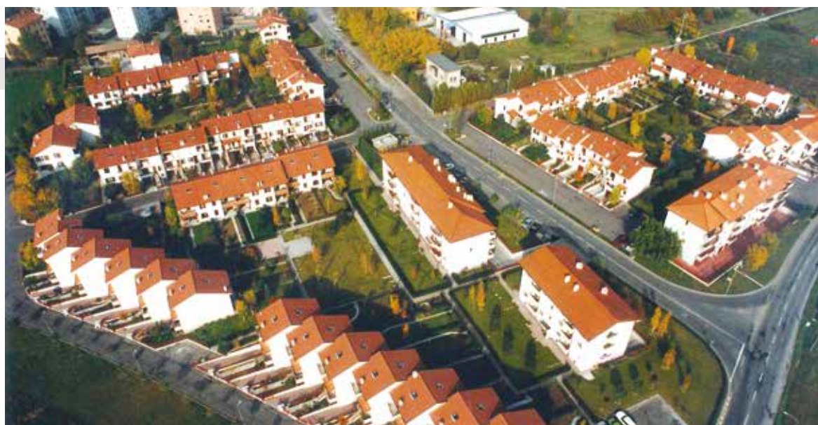
Intervento di 110 abitazioni a FIDENZA (PR) - 1985
