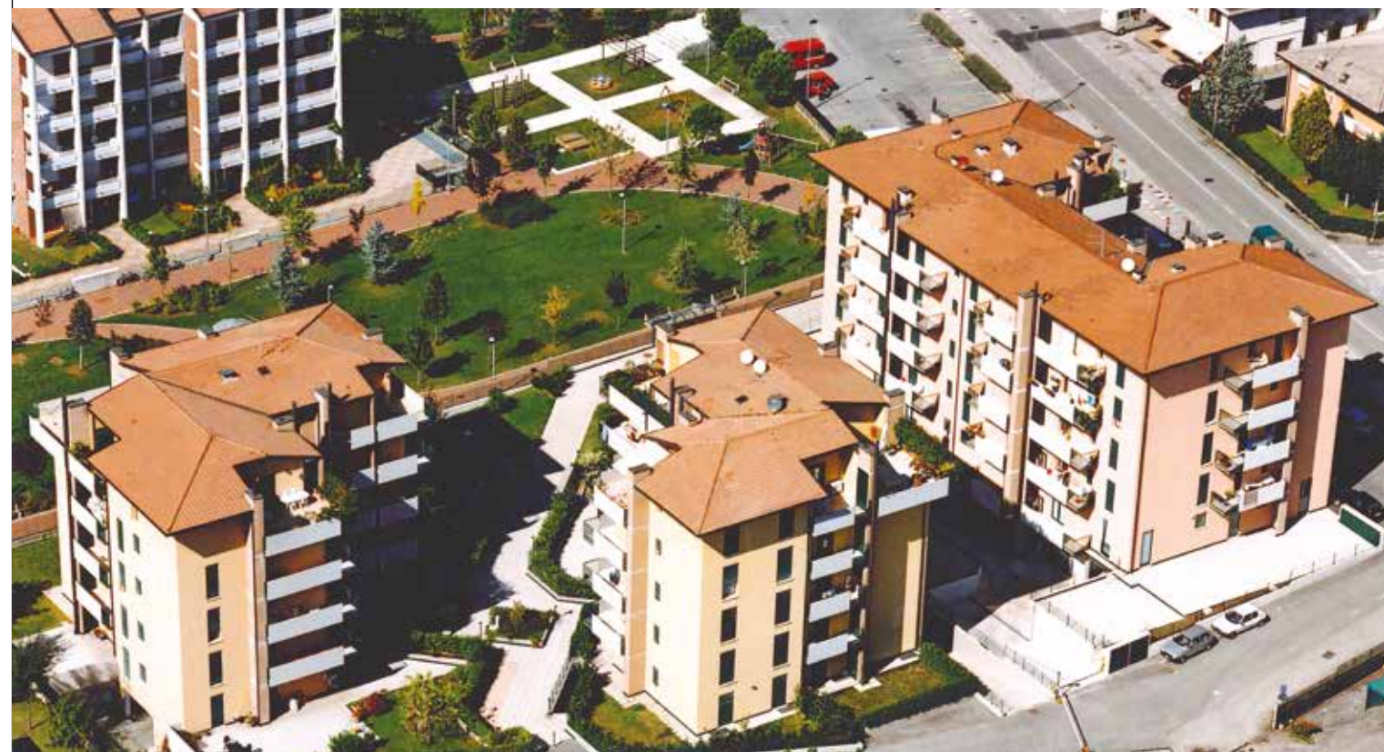
Intervento di 100 alloggi a VICENZA - 1998
