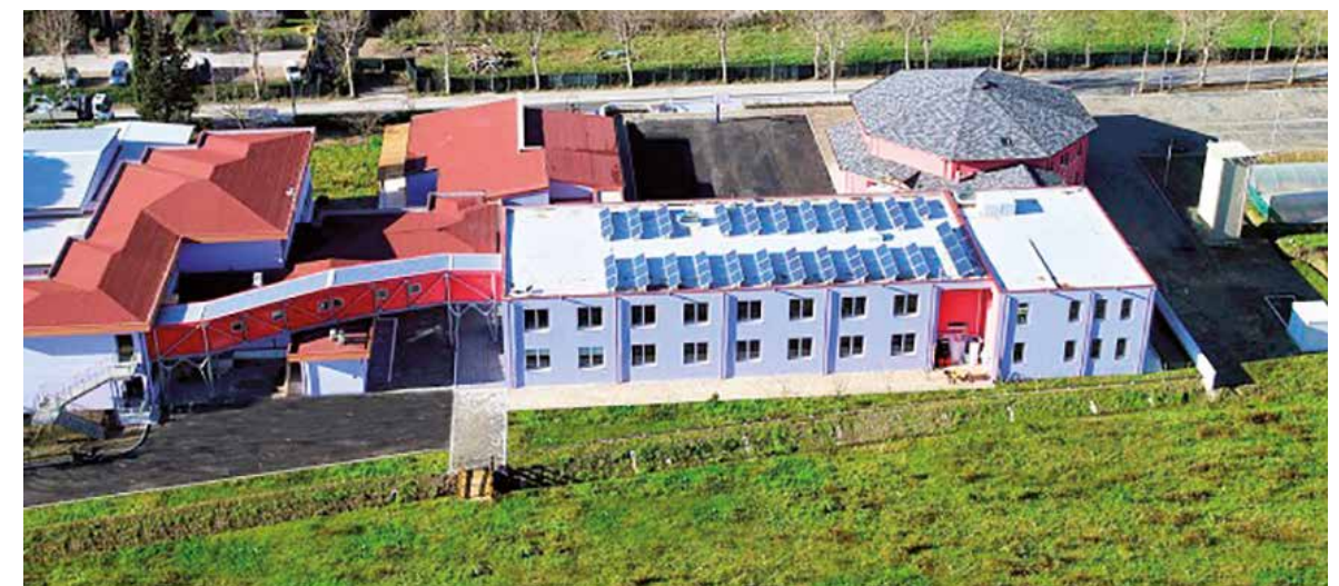
Edificio Scolastico a MASSAROSA (LU) - 2015
