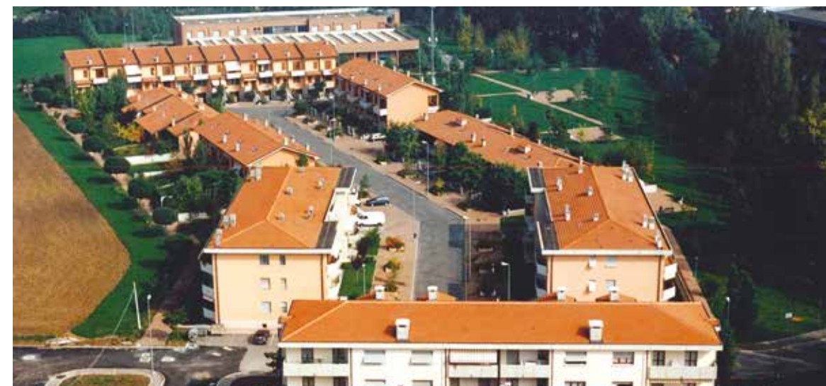
Quartiere di 80 alloggi a FIDENZA (PR) - 1989
