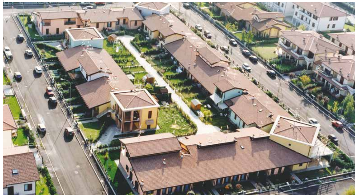
Intervento di 50 abitazioni a BRESCIA - 1994
