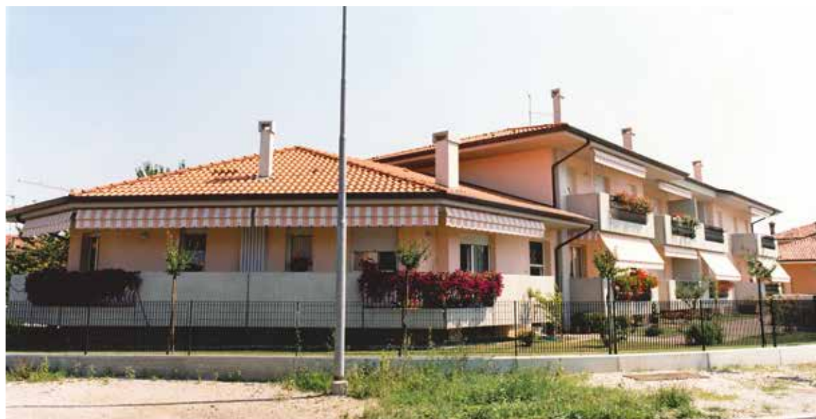
Intervento di 10 alloggi a UDINE - 1994
