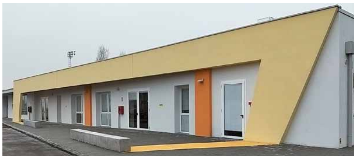
Edificio scolastico a SAN PROSPERO (MO) - 2019
