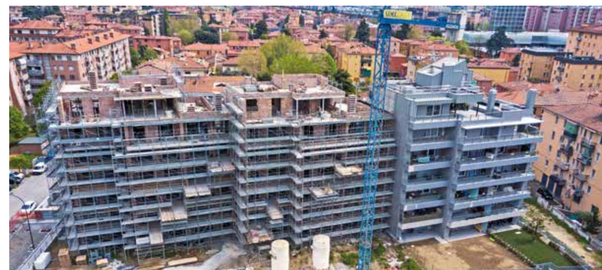
Intervento di 3 palazzine 7 piani a BOLOGNA - 2019
