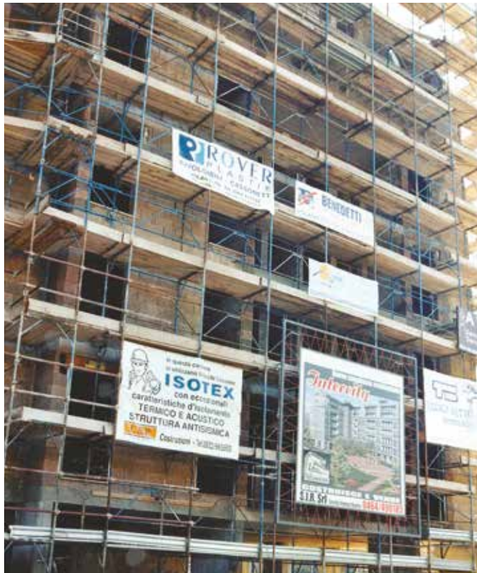
Intervento di 160 alloggi a ROVERETO (TN) - 2001
