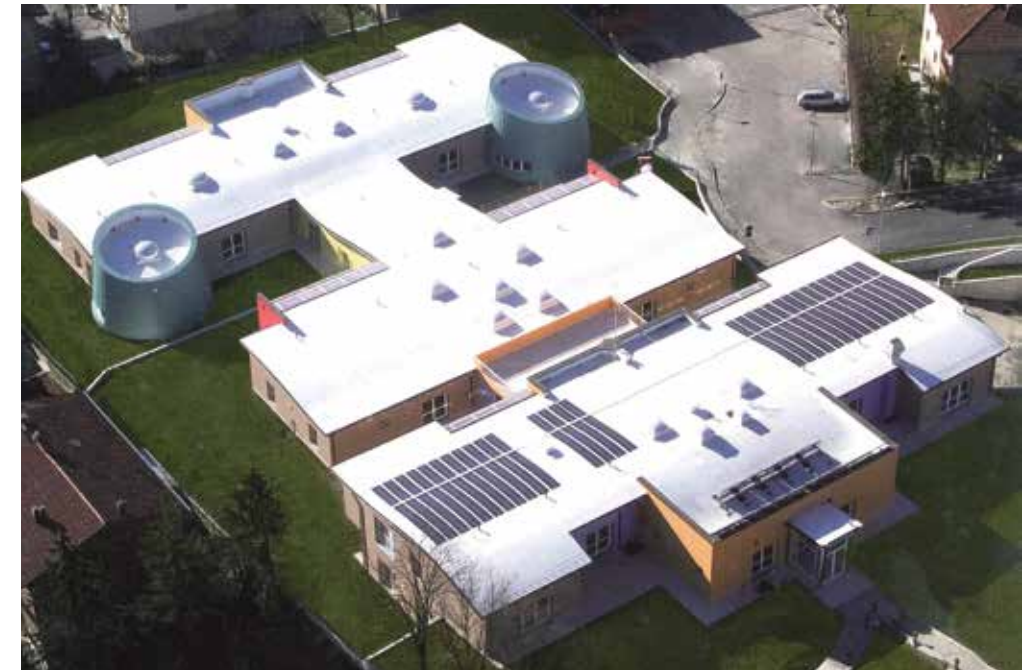
Edificio scolastico a PAVULLO (MO) - 2011
