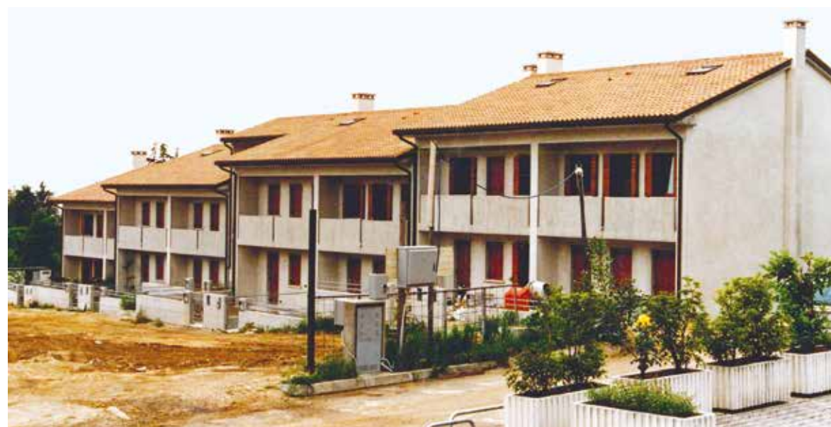
Intervento ville a schiera a PADERNO (TV) - 1994
