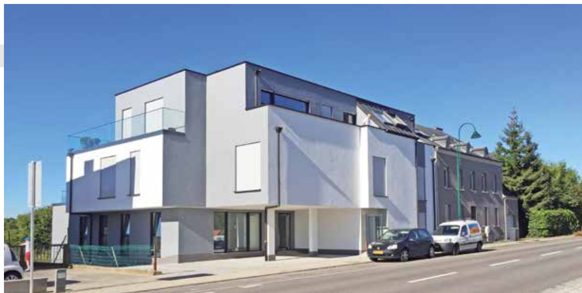
Complesso residenziale plurifamiliare in LUSSEMBURGO - 2015
