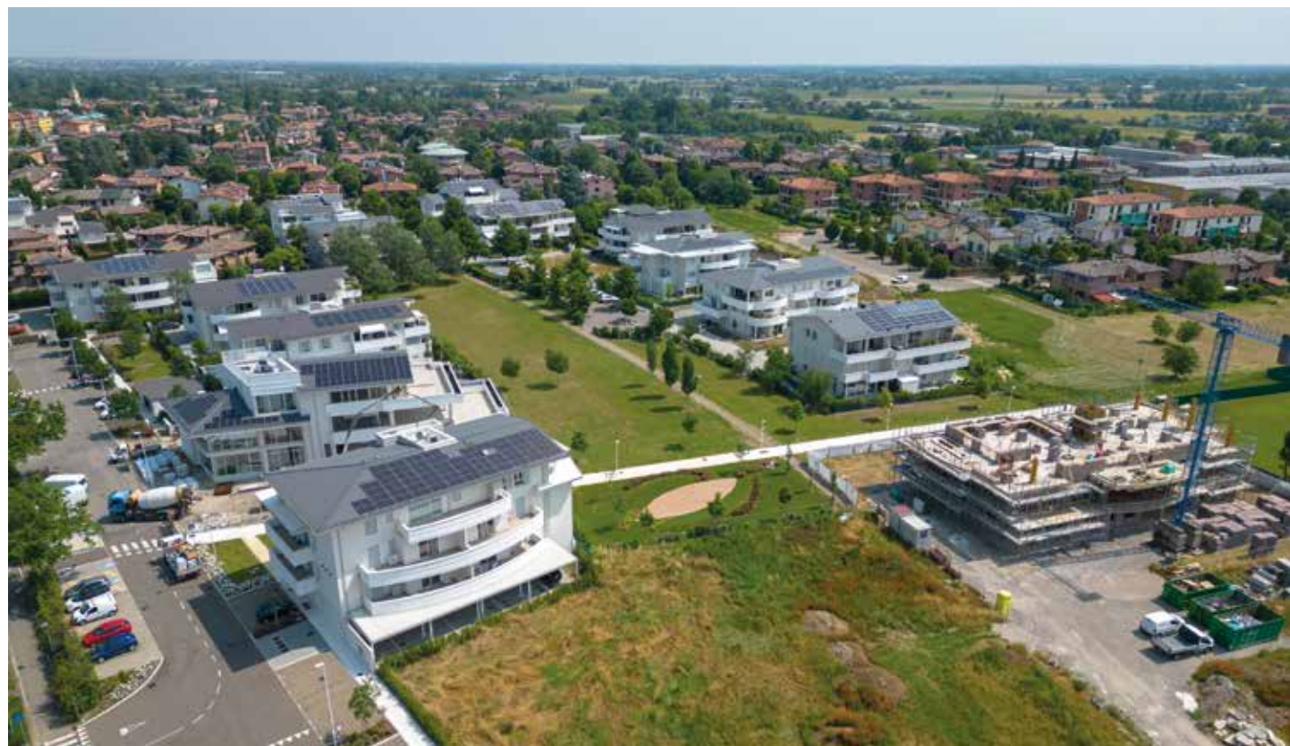
Quartiere ecosostenibile di 160 alloggi ECOVILLAGGIO MONTALE (MO) - 2011-2023
