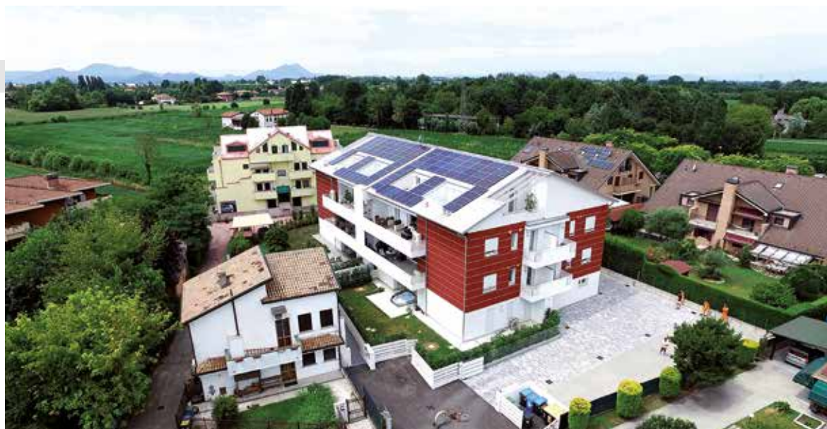
Edificio residenziale di 15 alloggi a MONTA' (PD) - 2017
