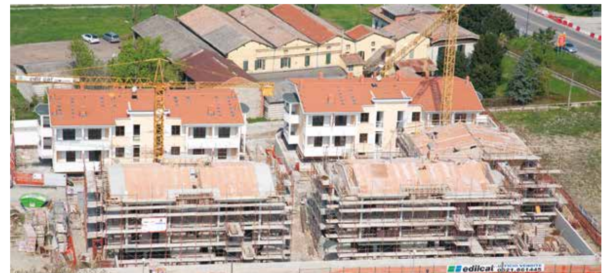
Intervento di 40 alloggi a PONTETARO NOCETO (PR) - 2008-2009
