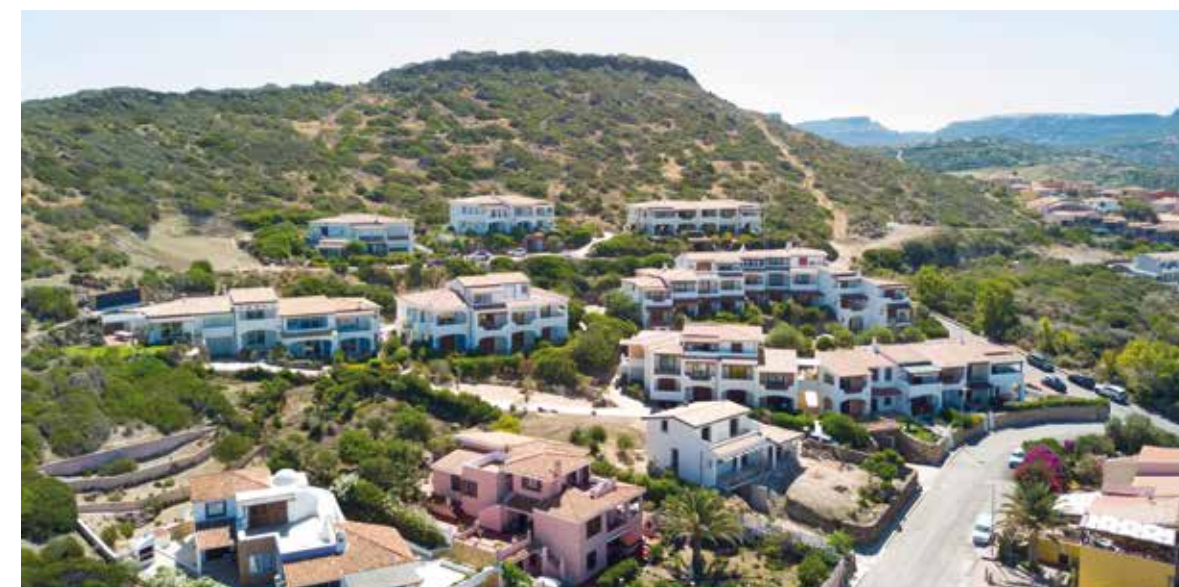
Complesso residenziale di 100 alloggi a CASTELSARDO (SS) - 2016
