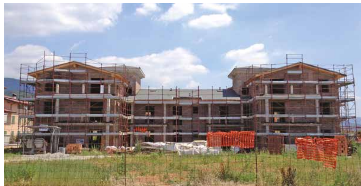
Intervento di 17 alloggi a RODENGO SAIANO (BS) - 2012
