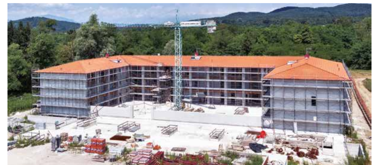
Intervento realizzato a SESTO CALENDE (VA) - 2011
