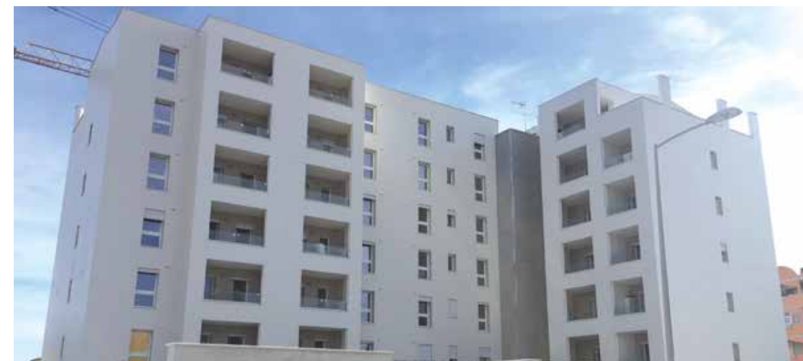
Edificio residenziale 7 piani a SELARGIUS (CA) - 2017
