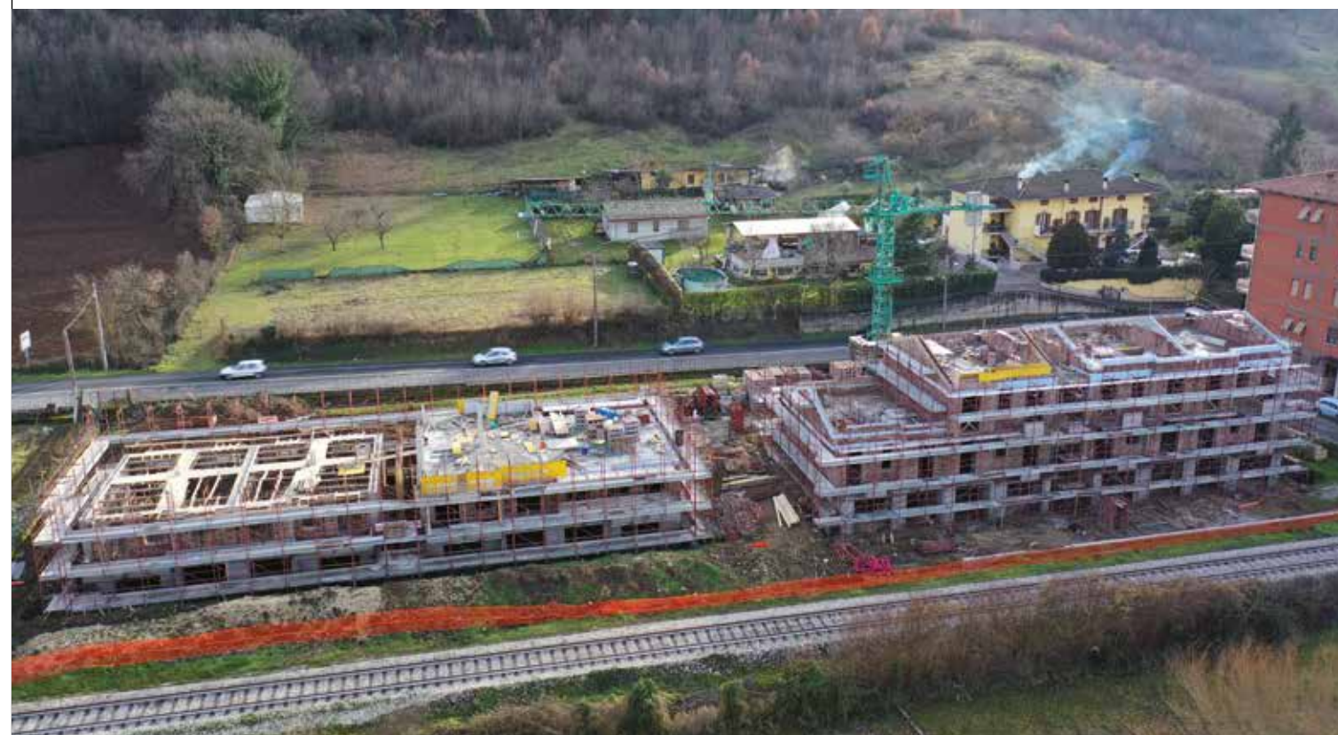
Intervento di 2 palazzine 16 alloggi a RIETI - 2020
