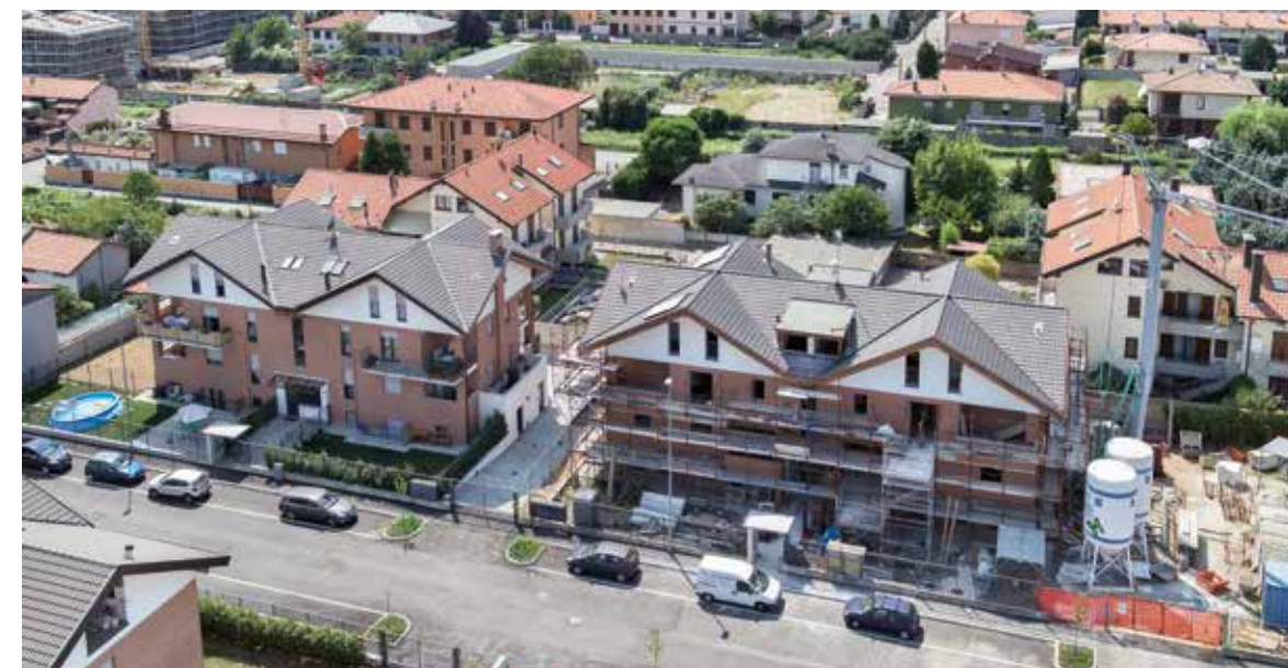
Intervento realizzato a CASOREZZO (MI) - 2010
