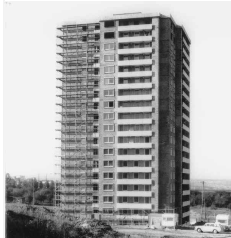
Edificio 17 piani a BAD WALDSEE - 1974
