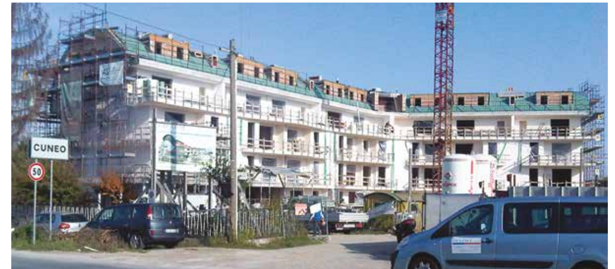
Intervento 36 alloggi a CUNEO - 2010
