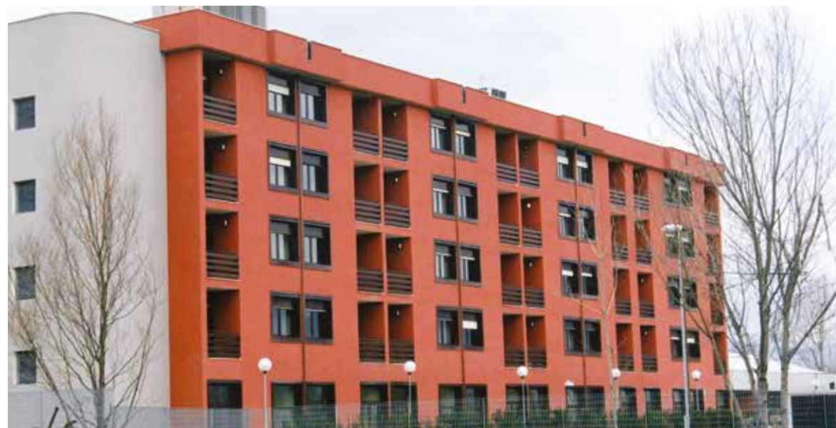
Intervento di 160 alloggi a PISA - 1999
