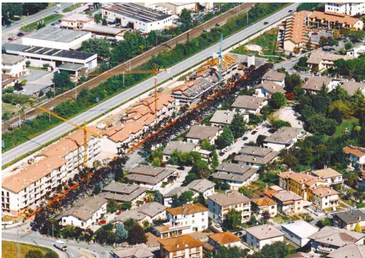
Intervento di 150 alloggi a VICENZA - 2001
