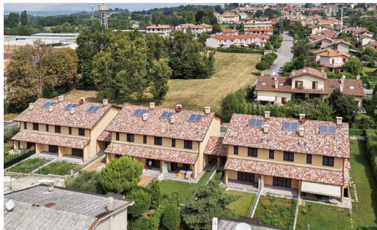
Intervento 9 alloggi BESANA BRIANZA (MB) - 2010
