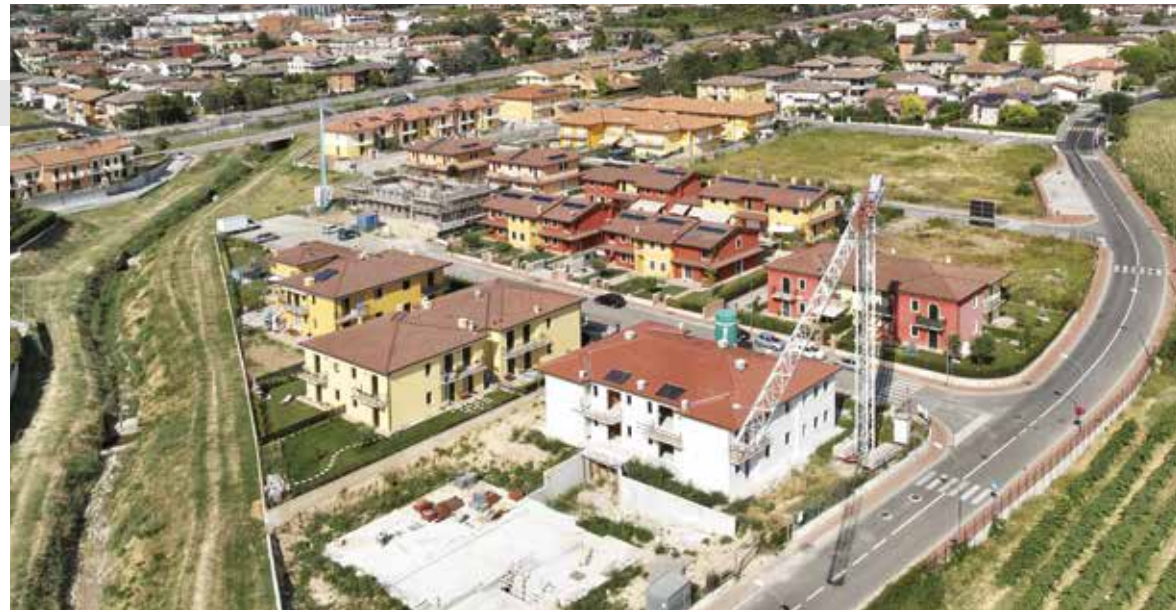
Intervento 20 alloggi a CALDIERO (VR) - 2009
