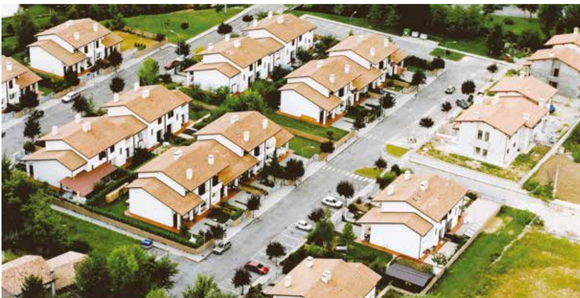
Intervento di 30 alloggi a VICENZA - 1989
