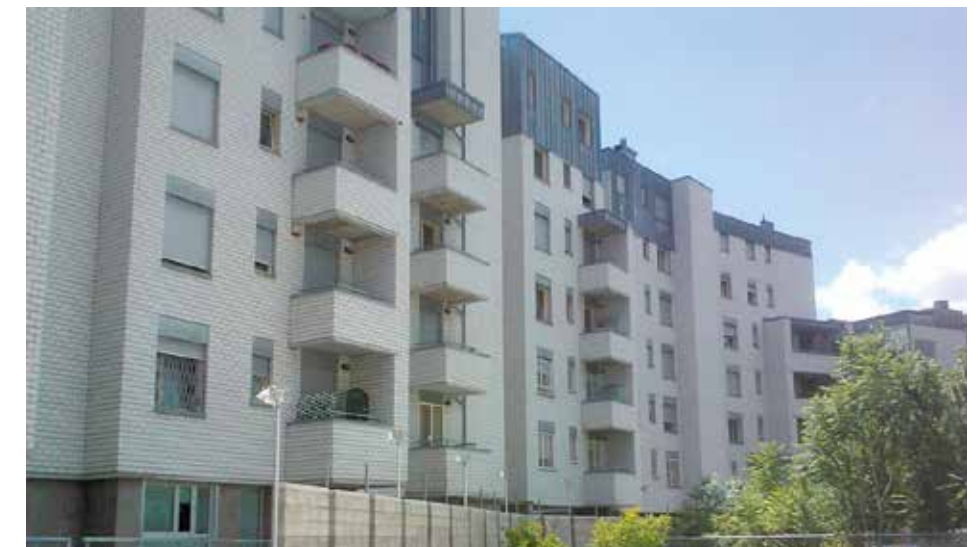
Intervento palazzina 6 piani a BOLOGNA - 2008
