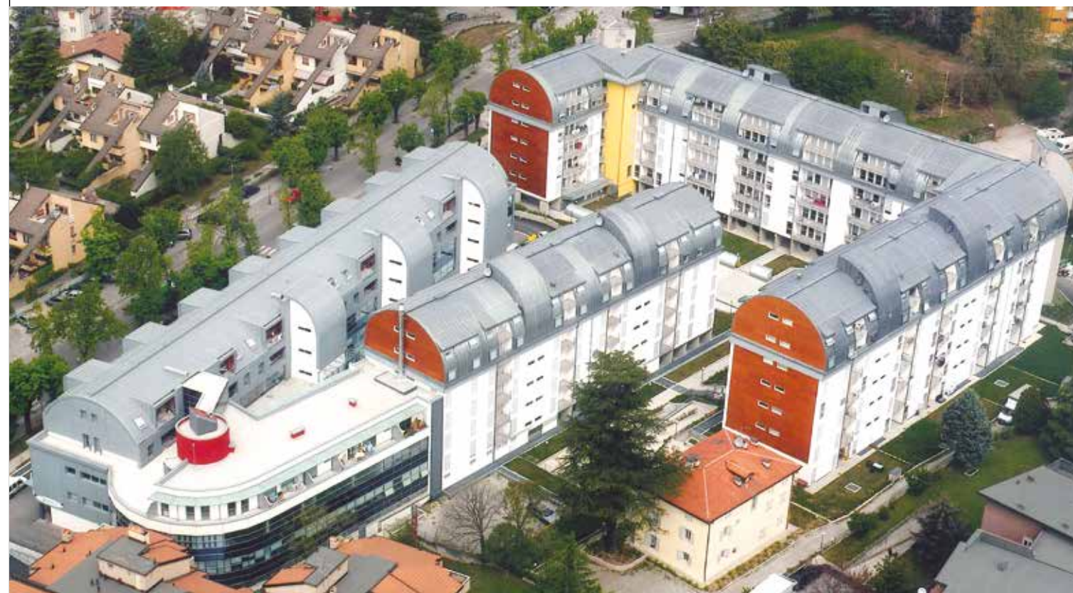
Intervento di 160 alloggi a ROVERETO (TN) - 2004
