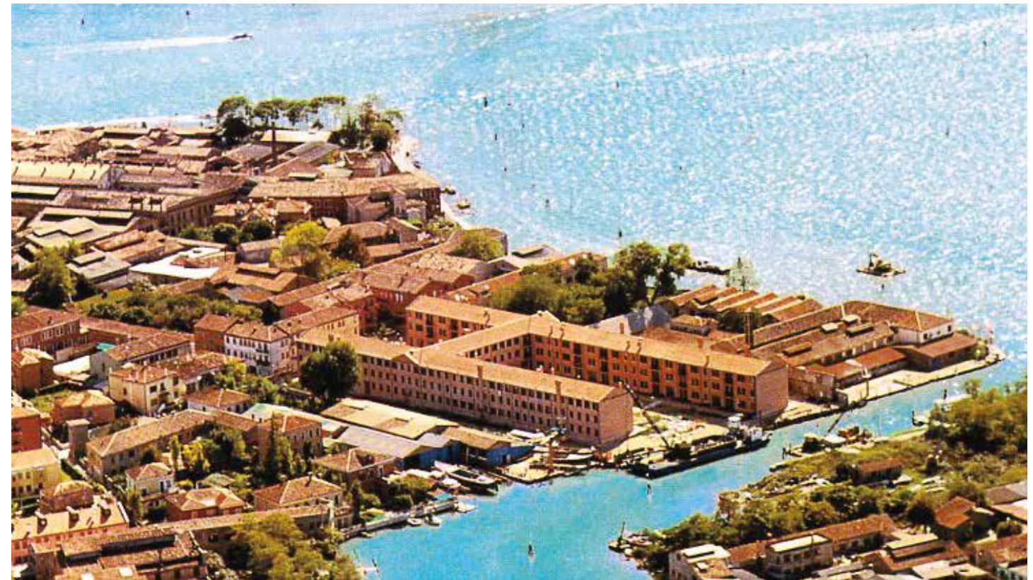
Intervento di 60 abitazioni a VENEZIA - 1993
