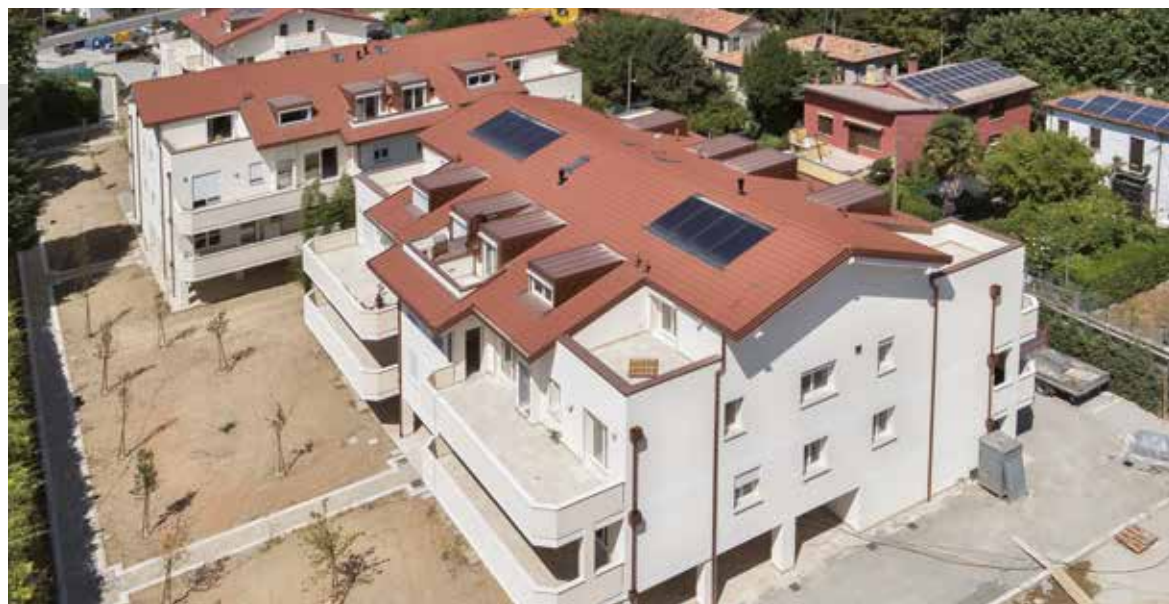
Intervento di 2 palazzine a PADOVA - 2011
