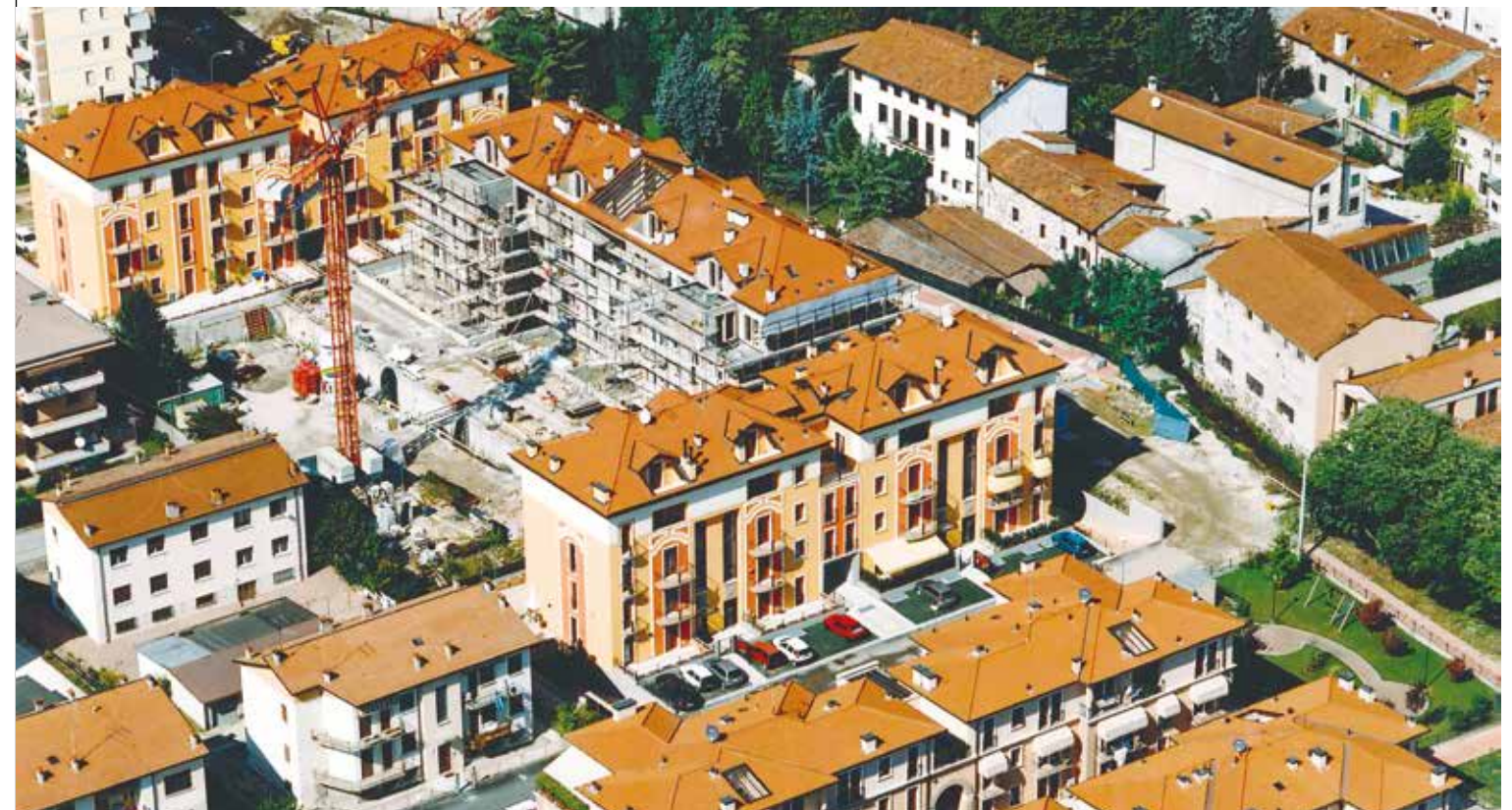
Intervento di 150 alloggi a VICENZA - 2001
