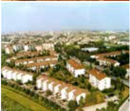
Quartiere Residenziale Fidenza (PR)
