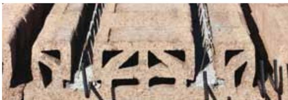
La placa de forjado, consiste en una placa semirresistente compuesta por piezas de CMC, y semiviguetas armadas. Posee unos valores excelentes de aislamiento térmico, y acústico. Y además, supone un soporte ideal para la realización de rozas, paso de instalaciones y aplicación de revocos.
